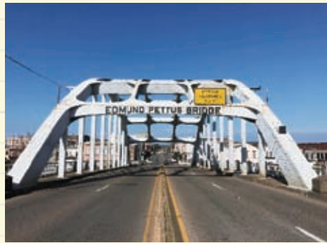
セルマの行進の出発点となった下マンド・ベタス橋
